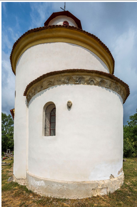
Rotunda v pohledu od východu. Foto: Marta Pavlíková 2019.
