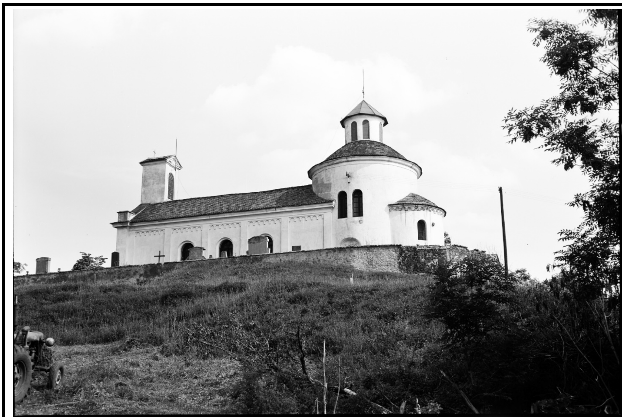
Celkový pohled od jihu. Foto: 1975, sbírka negativů NPÚ ÚOP v Ústí n. L., sign. 53106.
