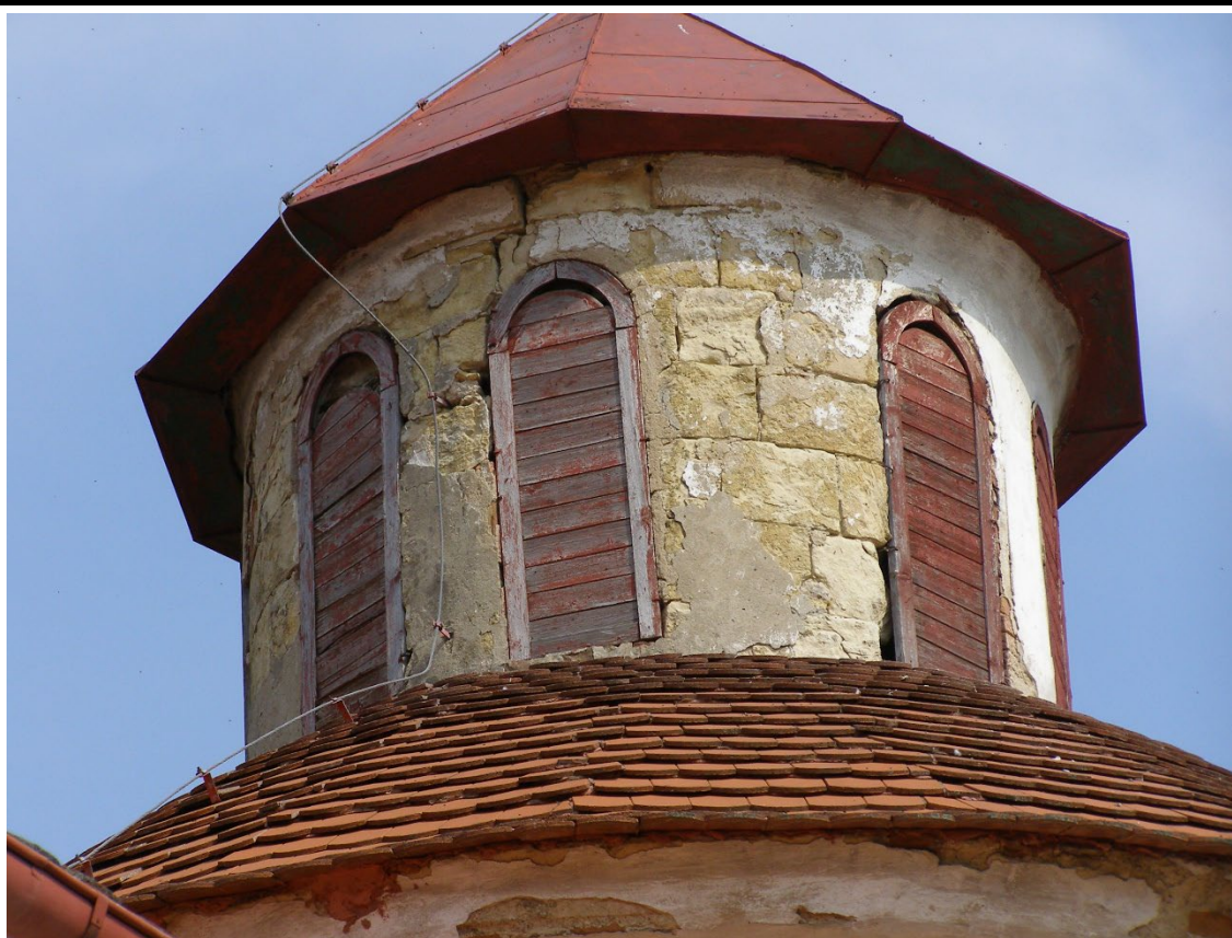
Detail lucerny rotundy v pohledu od jihozápadu. Foto: Jaroslav Skopec 2009.
