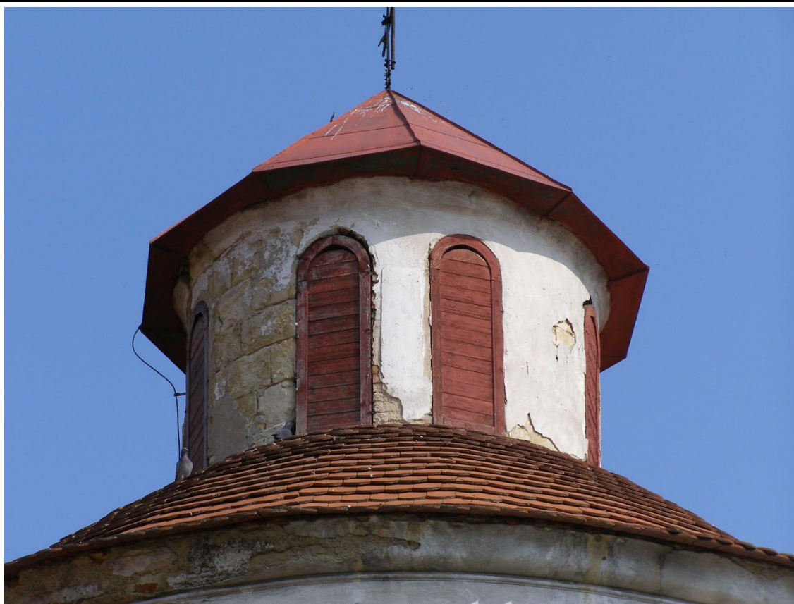
Detail lucerny rotundy v pohledu od jihu. Foto: Jaroslav Skopec 2009.
