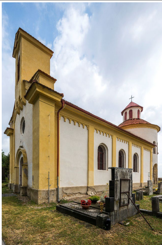
Celkový pohled od jihozápadu. Foto: Marta Pavlíková 2019.
