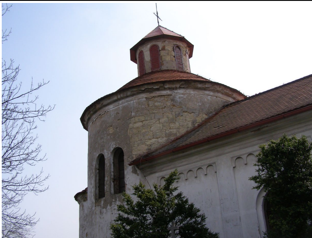
Vrchní partie lodi rotundy v pohledu od severozápadu s patrným románským kvádrovým lícem zdiva. Foto: Jaroslav Skopec 2009.
