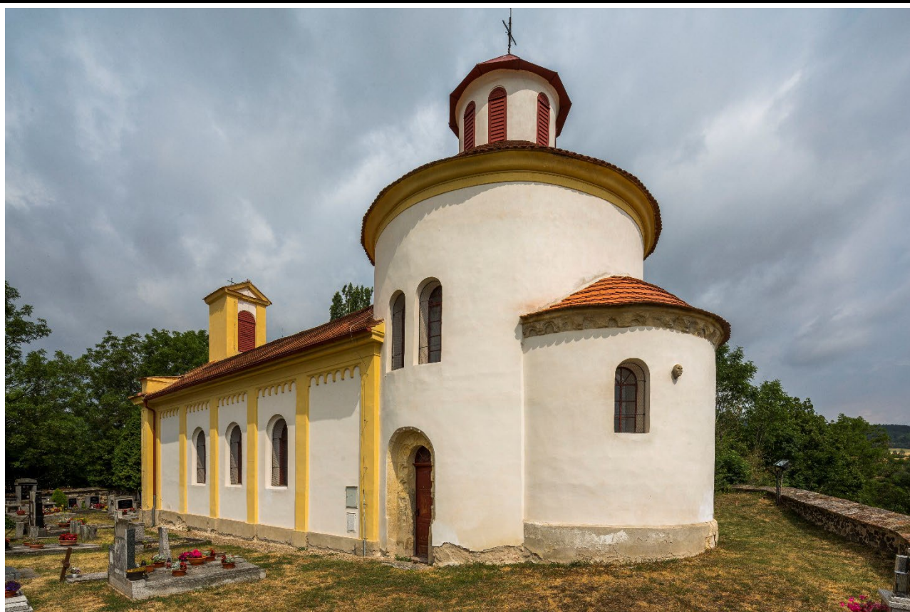
Celkový pohled od jihovýchodu. Foto: Marta Pavlíková 2019.
