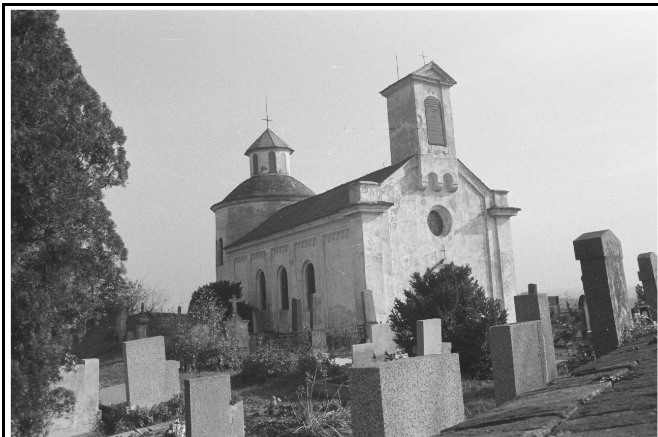
Celkový pohled od severozápadu. Foto: 1976, sbírka negativů NPÚ ÚOP v Ústí n. L., sign. 174296.
