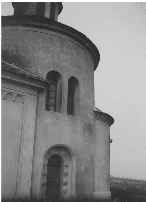
Rotunda v pohledu od jihozápadu. Foto: 1945, sbírka negativů NPÚ GŘ, sign. F054966.
