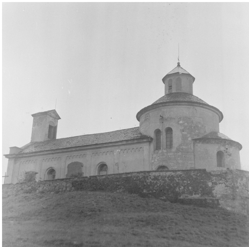
Celkový pohled od jihu. Foto: 1963, sbírka negativů NPÚ ÚOP v Ústí n. L., sign. 8398.
