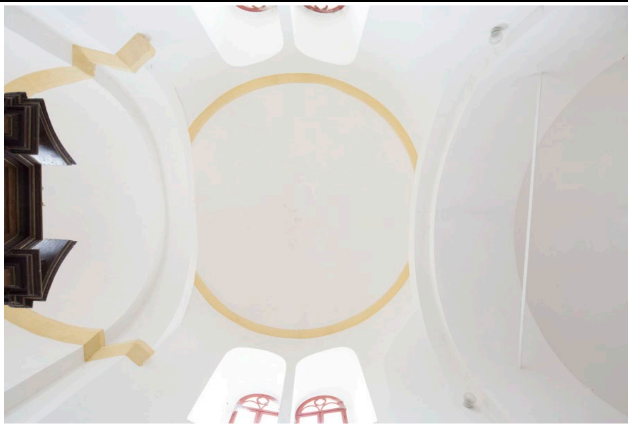
Kupole lodi rotundy část konchy apsidy v podhledu. Foto: Marta Pavlíková 2019.
