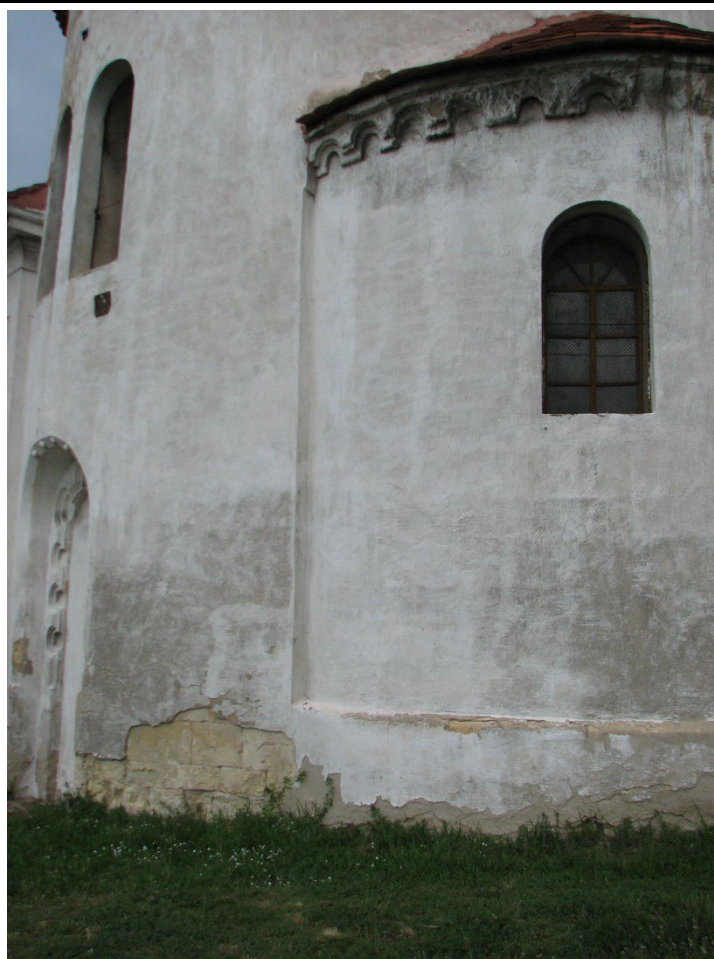
Rotunda v pohledu od jihozápadu s patrným kvádrovým zdivem lodi v místě, kde se připojuje apsida. Foto: Jaroslav Skopec 2009.
