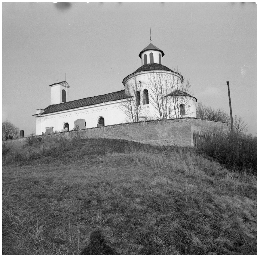
Celkový pohled od jihu. Foto: 1987, sbírka negativů NPÚ ÚOP v Ústí n. L., sign. 97313.
