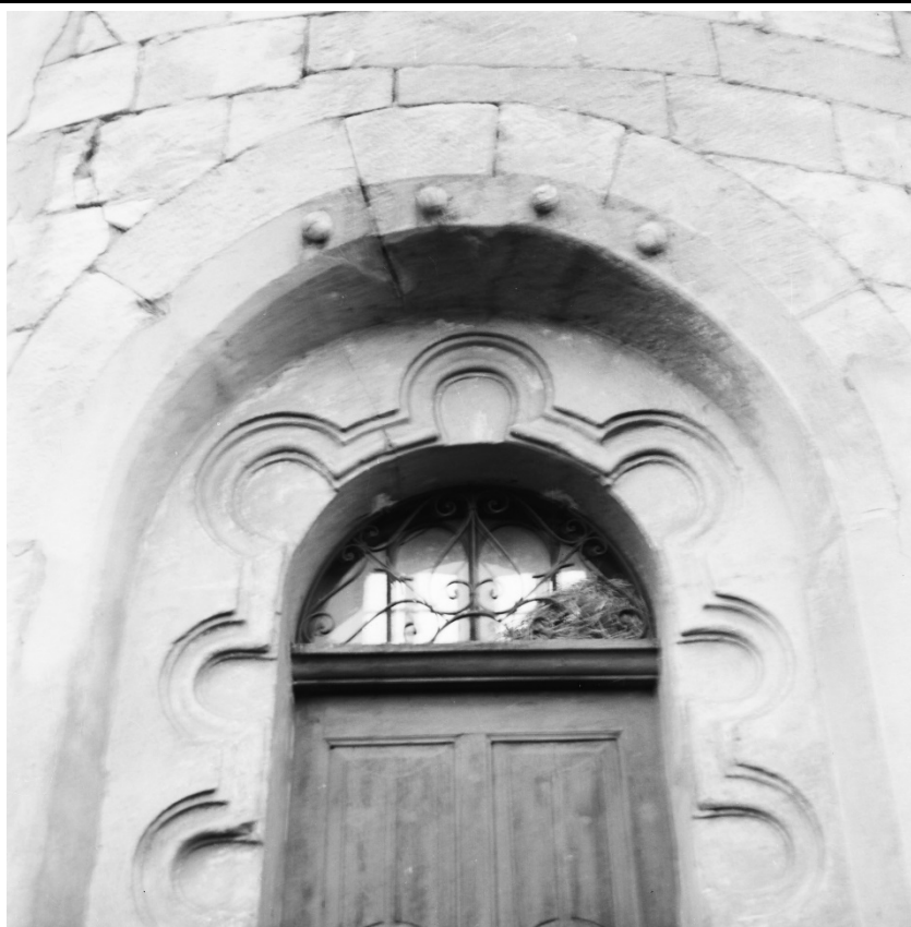
Detail portálu. Foto: 1966, sbírka negativů NPÚ ÚOP v Ústí n. L., sign. 24072.
