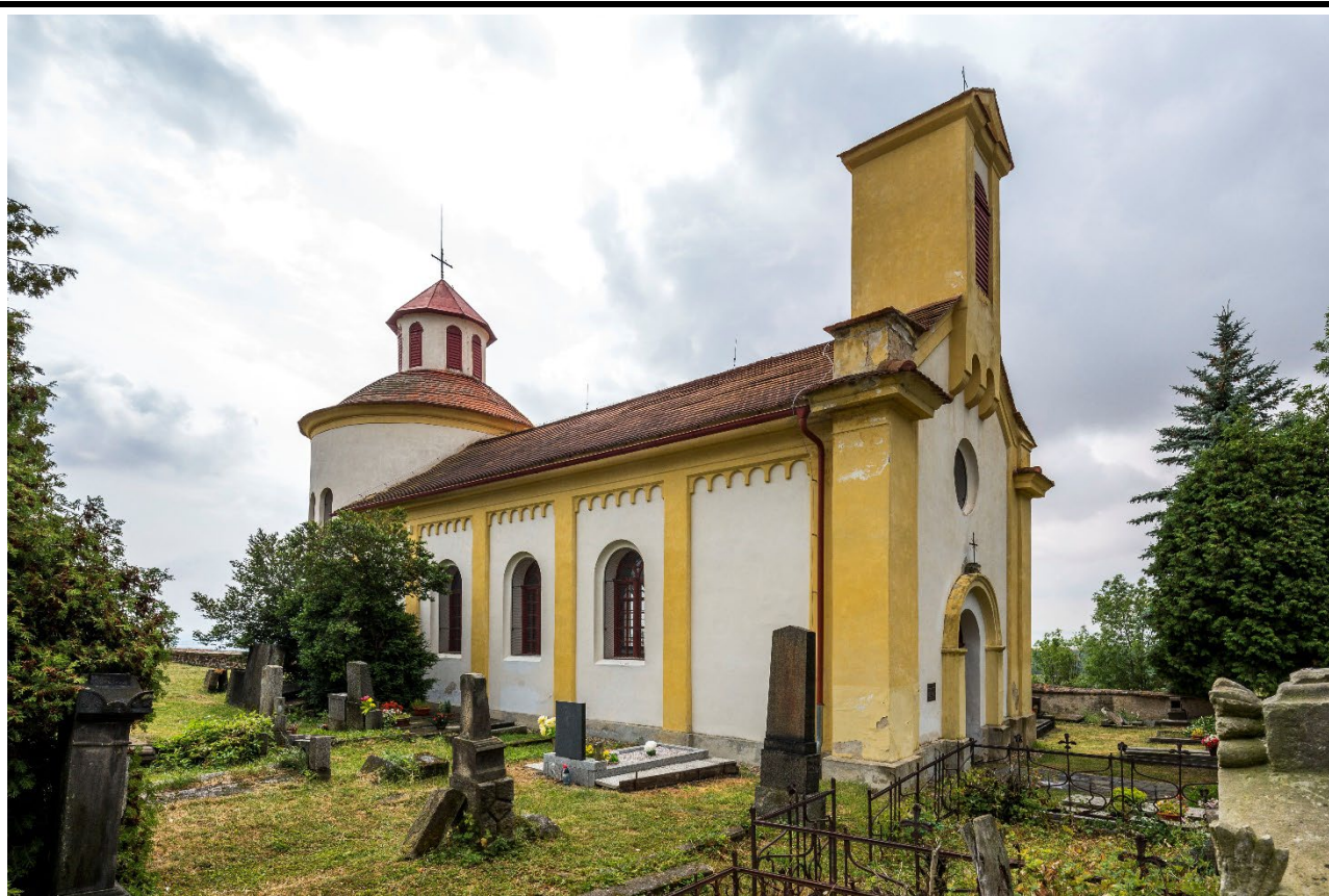
Celkový pohled od severozápadu. Foto: Marta Pavlíková 2019.
